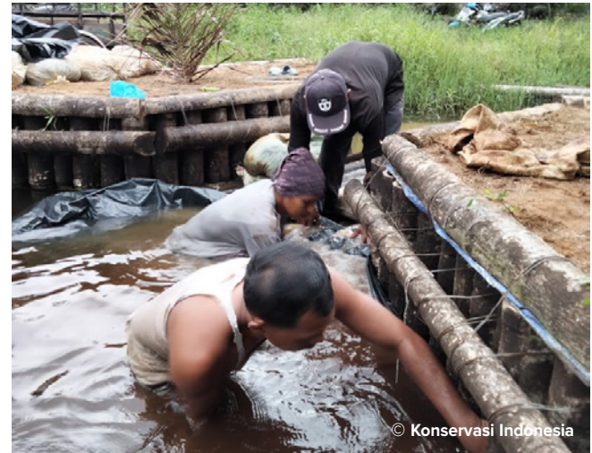
Masyarakat melakukan perawatan sekat kanal secara rutin.
