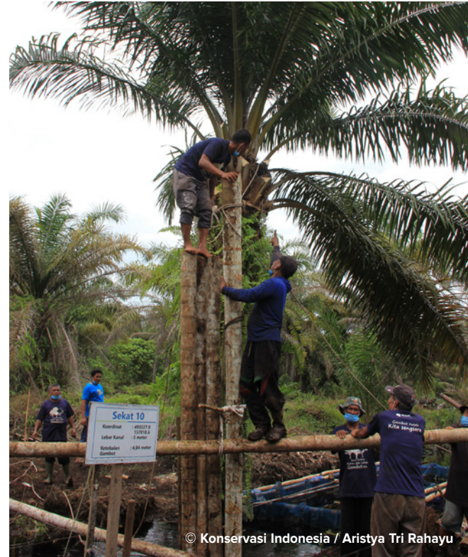
Pembangunan sekat kanal.
